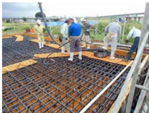
Рисунок 7. Укладка и уплотнение бетона
