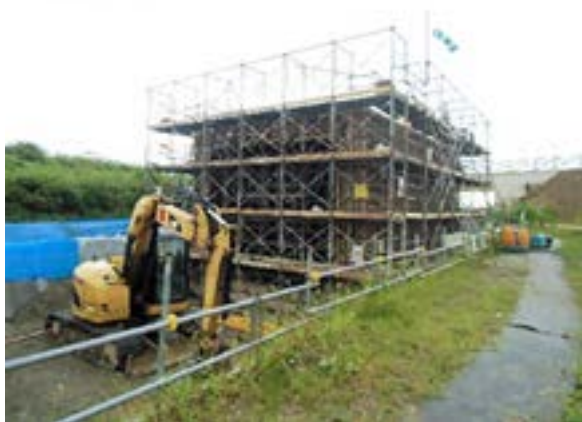
Рисунок 6. Строительная площадка коробчатого водопропускного канала в г. Нагаока
